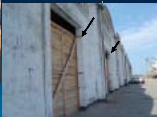
破損した扉が修復されている公共上屋
