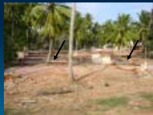
住居の破壊状況 (南西部海岸・Telwatta付近)
