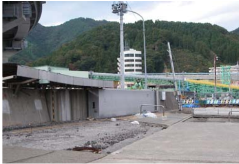
写真-6 海側の舗装の破損（地点 1-d の南側に隣接した部分）
