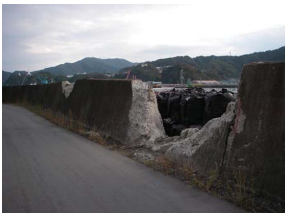
写真-8 漂流物による堤体の欠損（地点 1-f）
