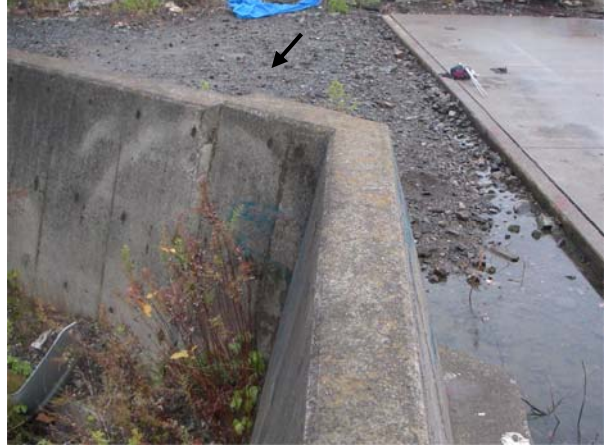
(2) 陸側からみた状況
