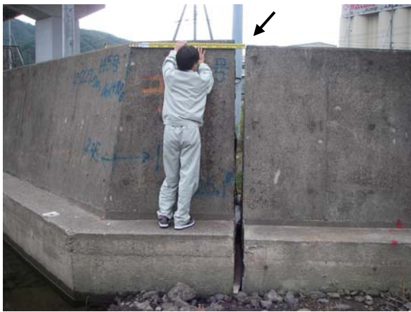
(3) 法線と平行な方向の目地開き (0.12m)
