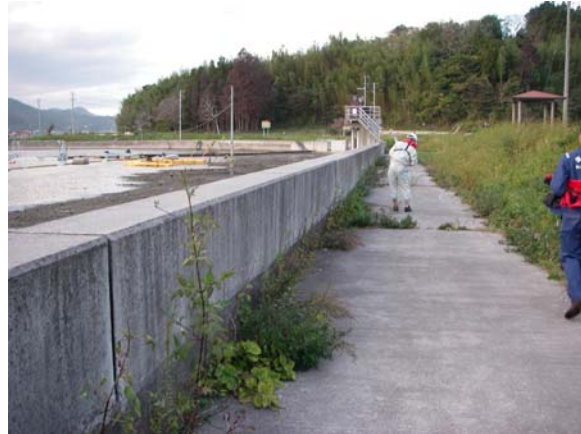
(3) 胸壁陸側の状況
