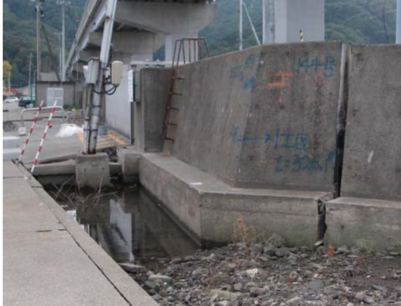
(1) 海側から見た状況
