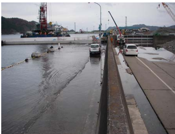
写真-1 被害のない胸壁（地点 1-a）
