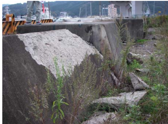
(2) 堤体同士の接触による堤体角部の欠損
