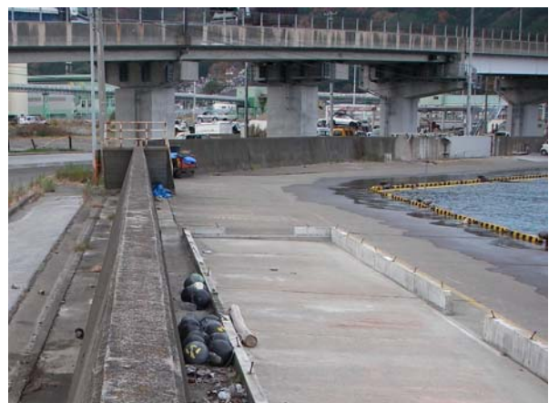
写真-2 被害のない胸壁（地点 1-b）
