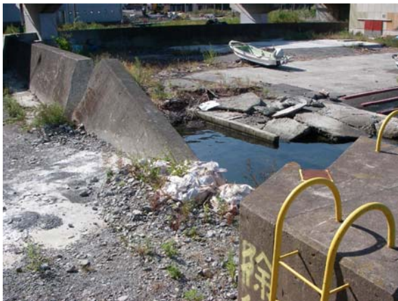
(1) 折れて変位した堤体。手前地盤は埋め戻し済
