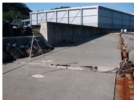
(4) 海側方向にずれ上がった床板
