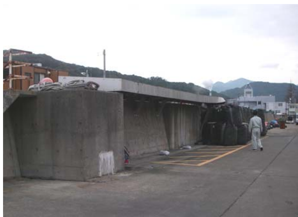
写真-3 応急措置として積み上げられた土嚢（奥側）と門扉の収納庫（手前）
