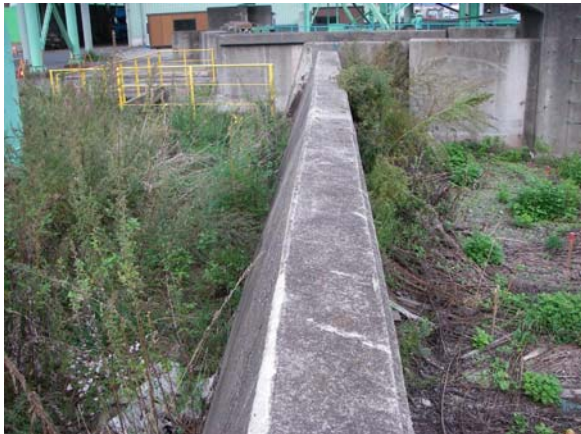
(1) 海側（右側）に傾斜した堤体
