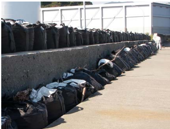
(3) 転倒した堤体の底面
