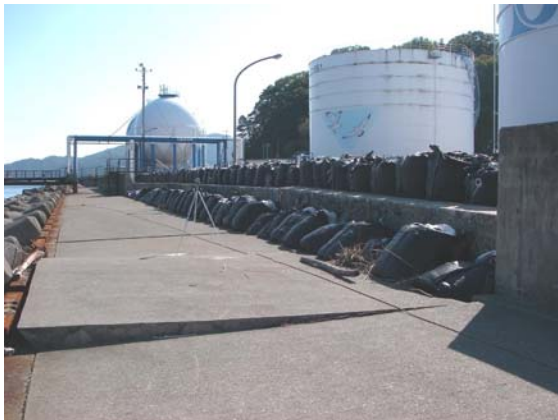
(1) 陸側に転倒した堤体
