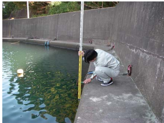
(3) 防潮壁の海側の状況
