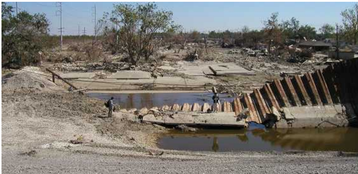
写真—2 9th Ward の破堤現場
