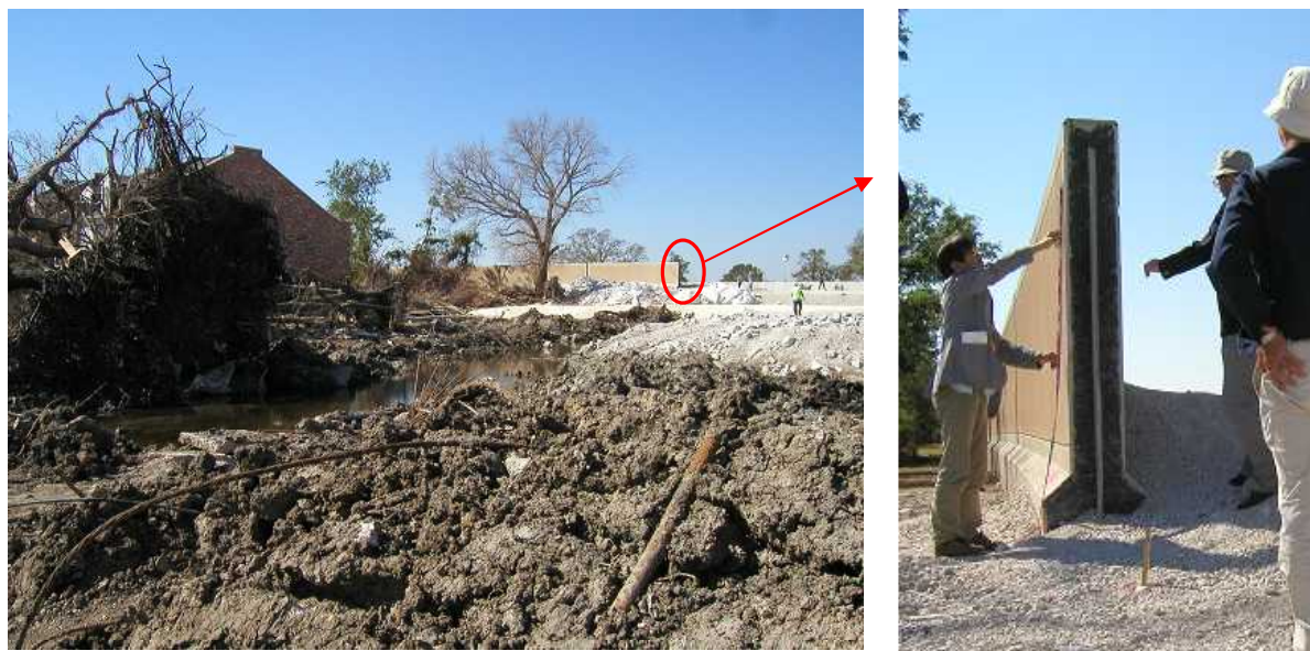
写真—1 17th Street Canal の破堤現場
