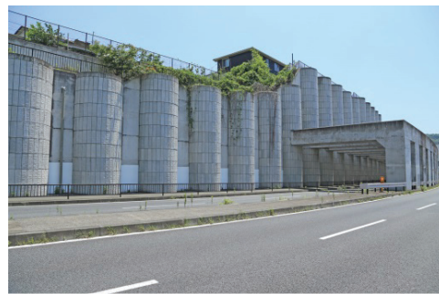
久里浜田浦線深礎擁壁（阿部倉）
