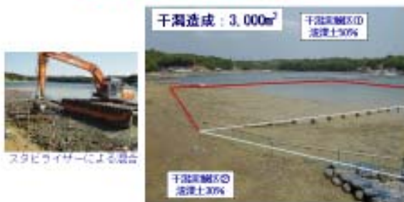
炭深土処理土の混合率を変化させた2つの実験区を造成
