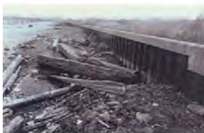
老朽化した護岸
