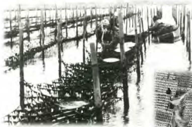
海苔網の修繕(昭和40年)
