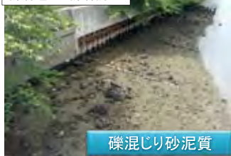
朝潮運河・朝潮橋
