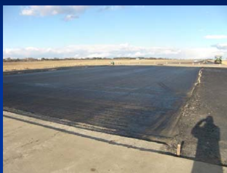
局所沈下部の打換え
