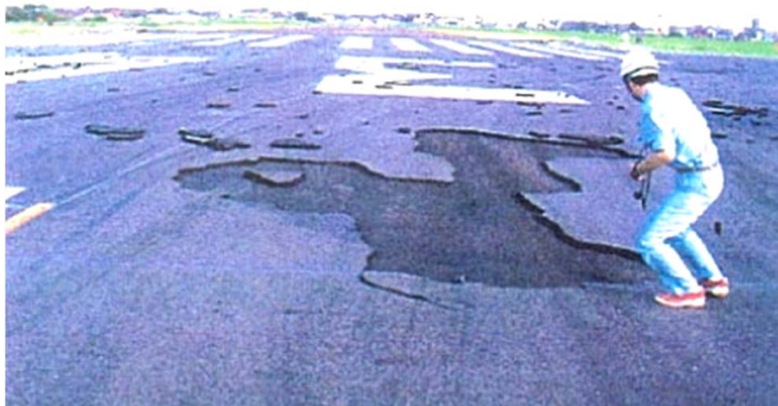
平成12年夏 名古屋空港での層間剥離・ブリストリングによる破損
