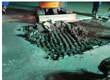
層間剥離部の緊急補修時に 切削してみたら基層がザクザクだった例
