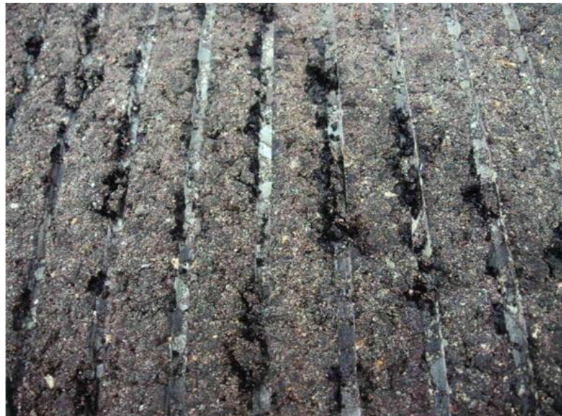
グルーピング施工直後に発生した目つぶれ・角欠け
