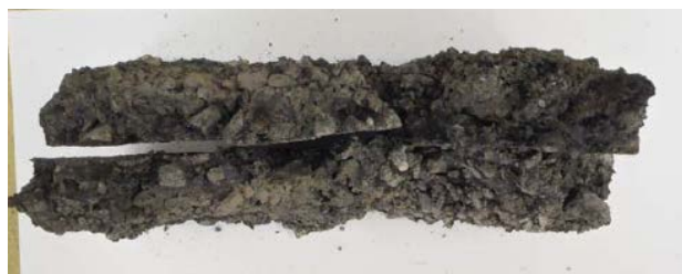
ストレートアスファルト(粒状化している)
