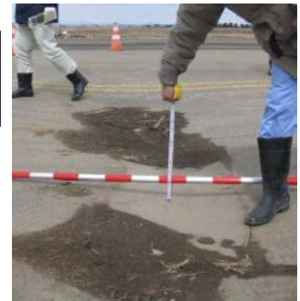
沈下箇所の拡大
