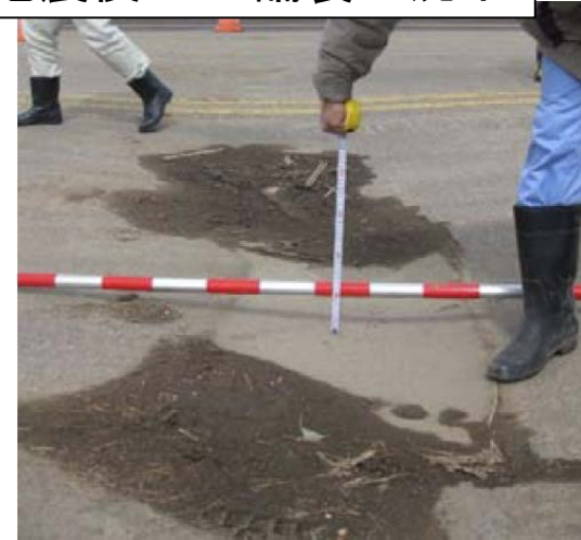
地震後のAs舗装の沈下
