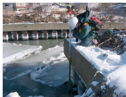
(1) 護岸の天端高の測定
