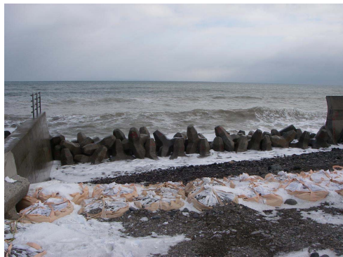
(2) 被災箇所を西側から見た状況
