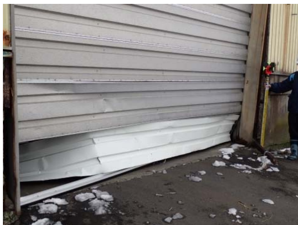
写真-2.5 根室港根室港区におけるシャッター損壊状況 (提供：根室港湾事務所)
