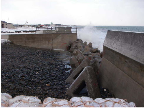
(1) 被災箇所を南側から見た状況
