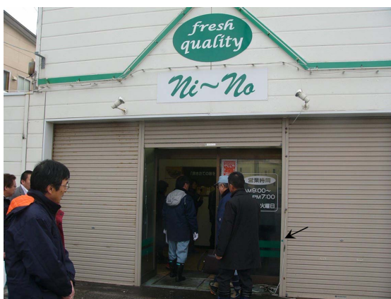
写真-付.F.1 緑町の浸水痕跡（矢印位置）
