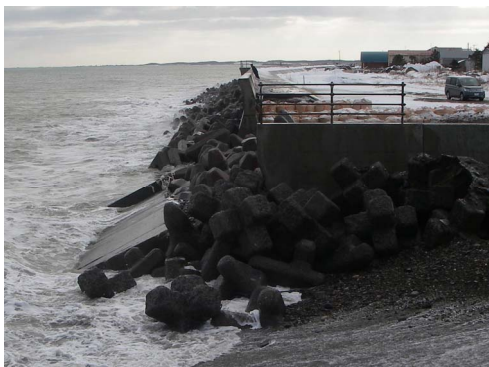
(2) 被災箇所を北側から見た状況
