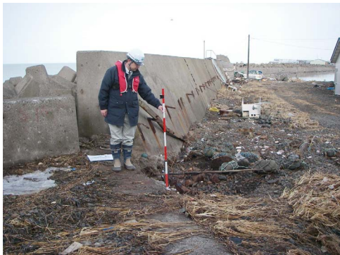
写真-4.18 地盤の洗掘（地点2-f）
