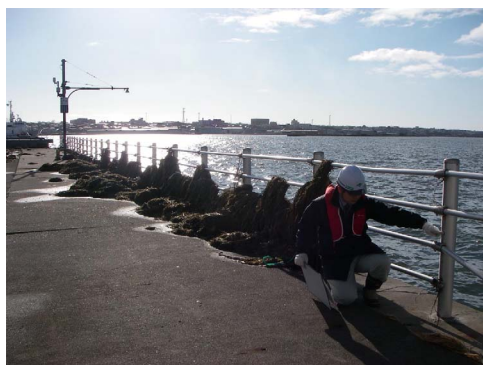
(2) 海藻が付着したガードレール
