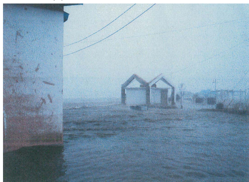
(3) 漁港内建物の浸水位置
