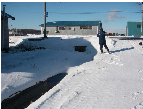
(2) 浸水経路と考えられる小規模な水路 (写真左下から調査員左側を通る水路)
