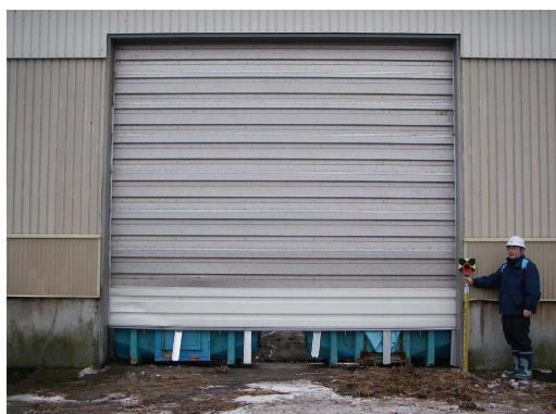
(2) ロールシャッターの被害例
