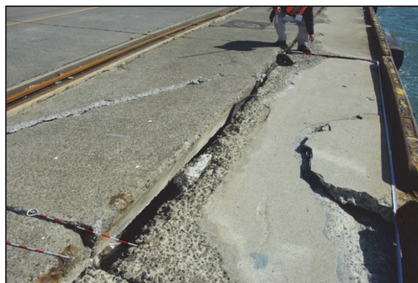
写真-5.9 舗装工の損傷（西港区第3埠頭） （提供：釧路港湾事務所）
