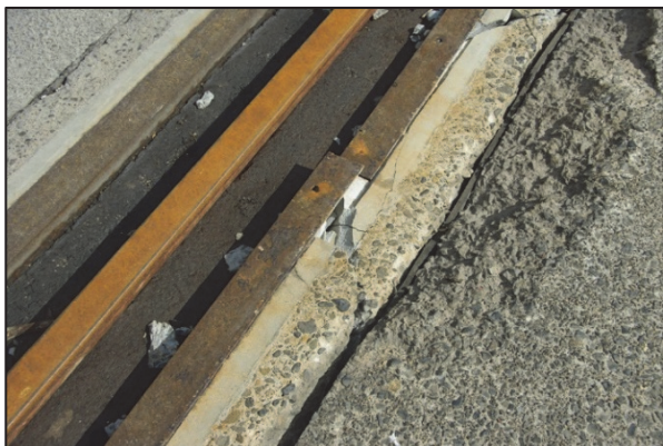
写真-5.11 ガントリークレーンのレール基礎の損傷 (西港区第3埠頭) (岸壁法線は右側) (提供：釧路港湾事務所)
