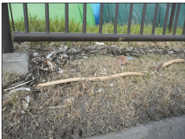
写真-5.15 浸水痕跡 (地点③)
