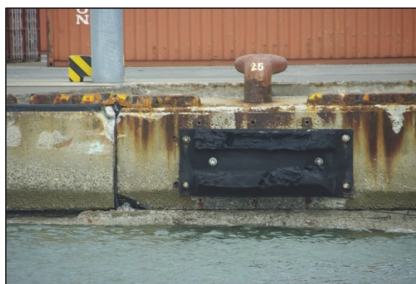
写真-5.10 防舷材の損傷（西港区第3埠頭） （提供：釧路港湾事務所）
