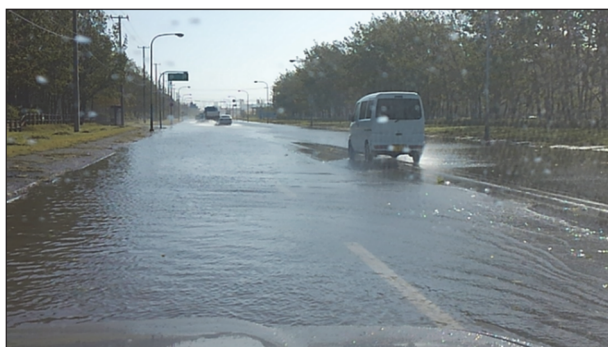
写真-5.7 西港区の浸水状況（地点④） （10月2日9時20分撮影） （提供：釧路市水産港湾部）
