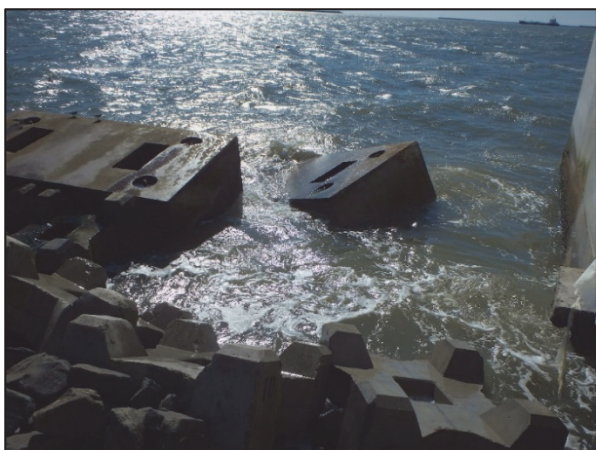
写真-5.12 被覆ブロック・方塊の飛散 (西港区海面処分場) (提供：釧路港湾事務所)
