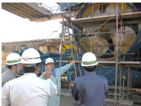
写真-4.2 推進器の調査状況
