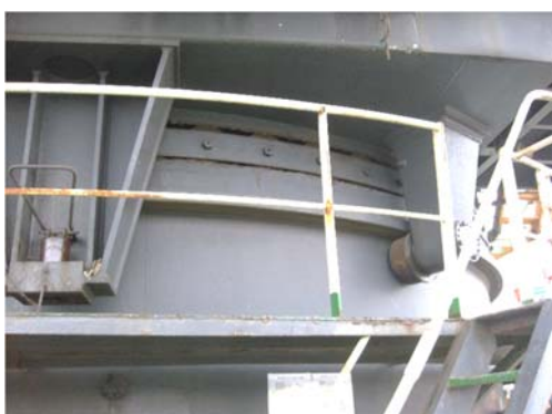
写真-4.8 クレーン旋回台の取付状況
