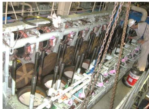
写真-4.4 主発電機開放状況
