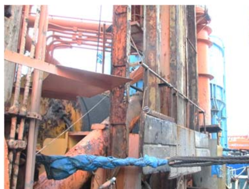
写真-4.10 掘削攪拌装置の状況
