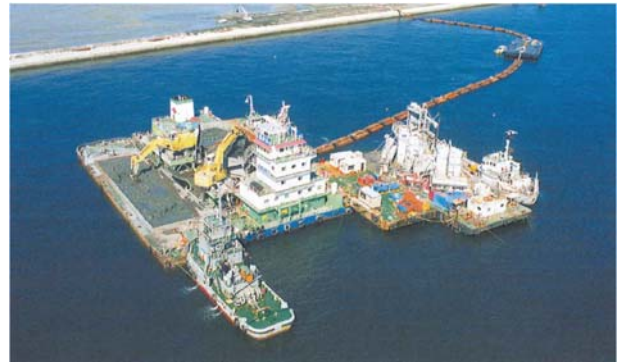
写真-A.6 揚土船 (空気圧送船) 2)
