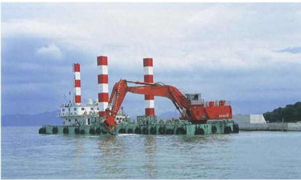
写真-A.3 バックホウ浚渫船 2)
