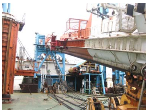
写真-4.7 杭打リーダーの船上格納状況
