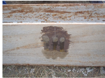
写真-4.22 計測箇所拡大（土中部側）
