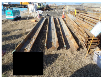
写真-4.5 控え工全景
