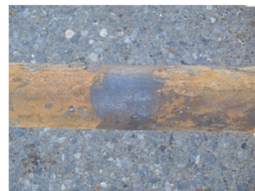
写真-4.19 タイロッド腐食状況
