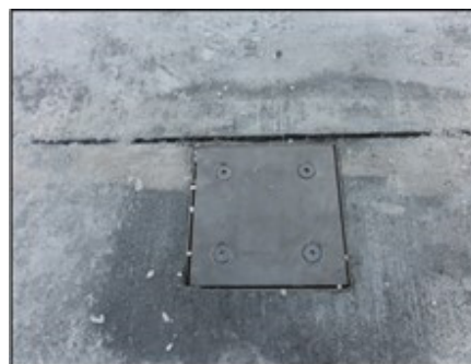
写真-2.5 構造1 設置完了 (ふた閉口状態)
