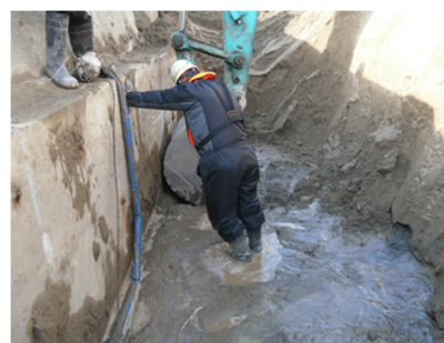
写真-4.12 タイワイヤー調査状況
