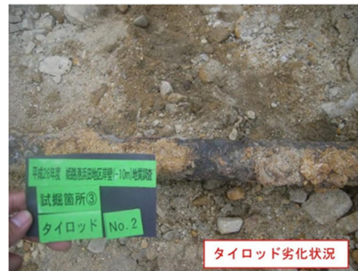
写真-4.15 タイロッドの腐食状況
