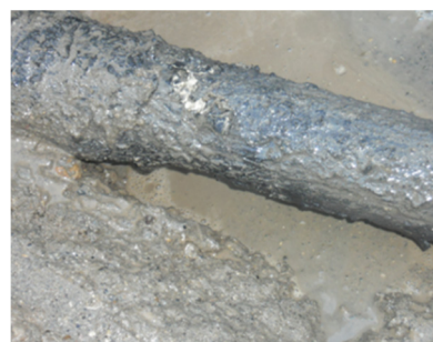
写真-4.13 タイワイヤー調査箇所
