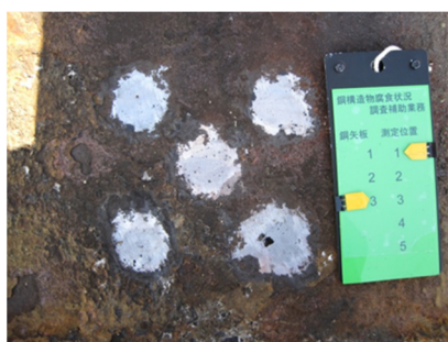
写真-4.7 計測箇所拡大 (No.3 : -0.2m)
