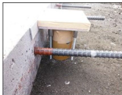
写真-2.4 蓋およびボイド管設置
