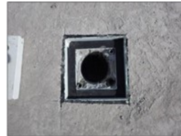
写真-2.6 常温注入目地・パッキン設置完了
