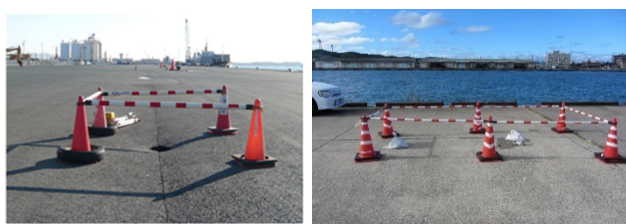
写真-2.1 空洞発生が確認された箇所の舗装の状況
