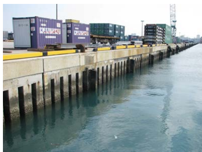
写真-3.1 岸壁の状況 (2015年2月)
