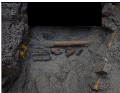
写真-4.2 タイロッド腐食状況
