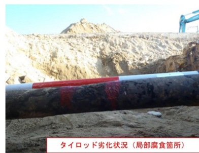
写真-4.17 タイロッド(局部腐食箇所)の腐食状況
