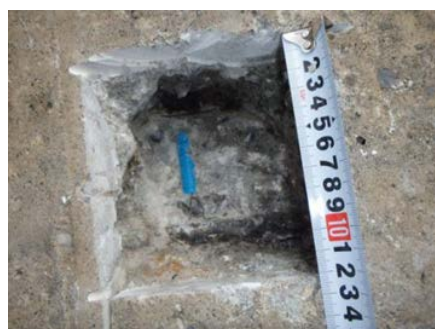
写真-3.2 鉄筋腐食確認状況
