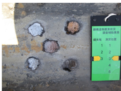
写真-4.8 計測箇所拡大 (No.3 : -4.2m)
