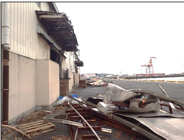
写真 5-11 上屋防潮扉への被害 (和歌山下津港)
