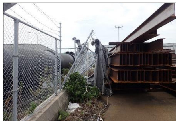
写真 5-4 フェンス倒壊（阪南港）
