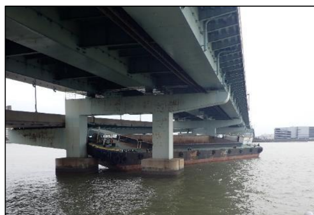
写真 5-10 台船が橋脚に衝突（尼崎西宮芦屋港）
