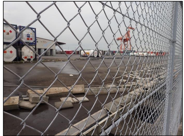
写真 5-12 側溝の散乱 (和歌山下津港)
