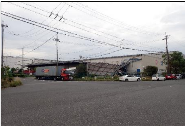
写真 5-5 上屋への被害 (堺泉北港)
