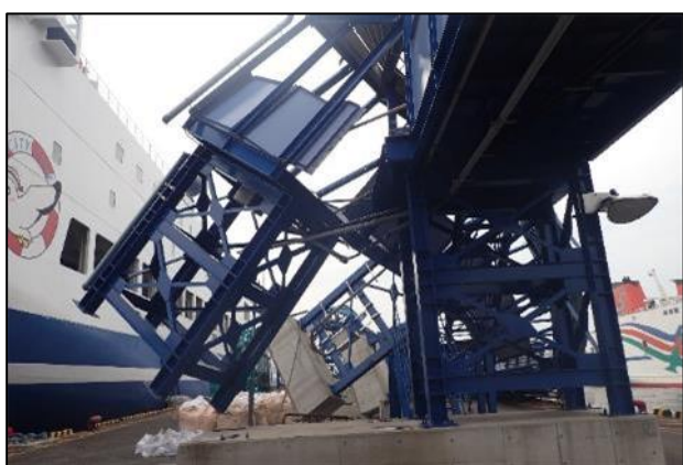
写真 5-3 ボーディングブリッジ倒壊（大阪港）
