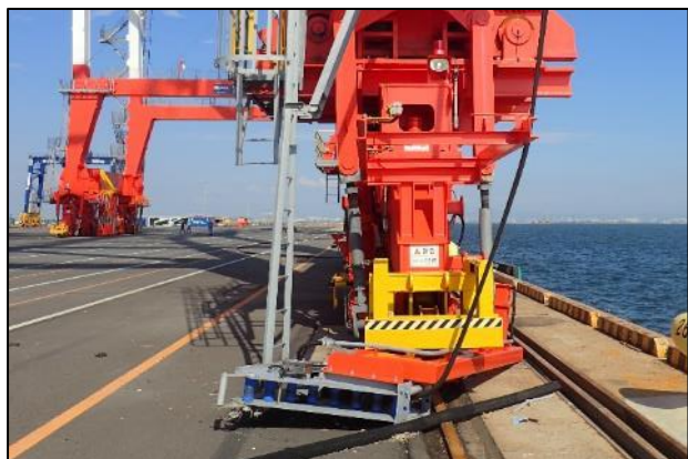
写真 5-8 ガントリークレーン電源施設被害（神戸港）
