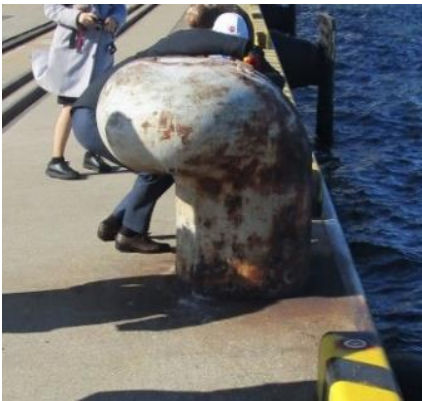
写真-3.2 横浜港本牧ふ頭の係船曲柱
