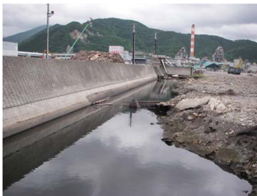
写真-22 前面側地盤の洗掘 (地点 n)
