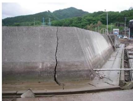
写真-5 堤体に発生したクラック (地点 d)
