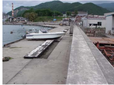
写真-20 胸壁の周辺状況 (地点 l)
