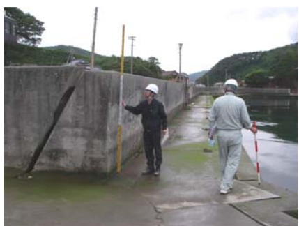
写真-7 堤体のすり合わせ部の開き (地点 f)
