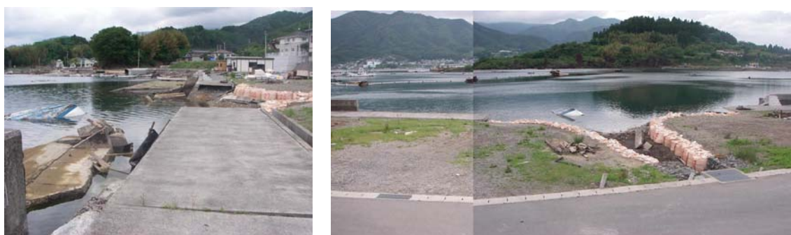
写真-12 堤防構造の被害（地点 h）
