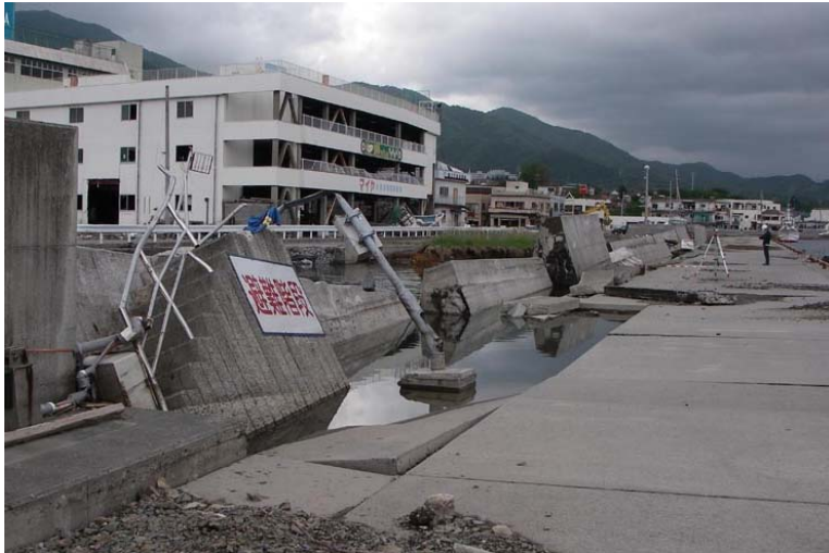
写真-27 背後側に倒壊した堤体 (地点 r)
