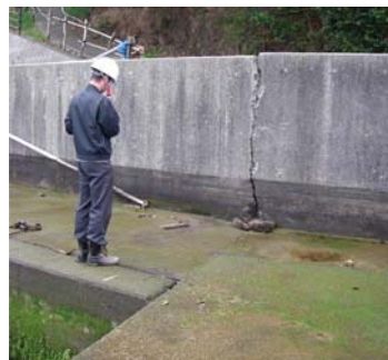
写真-6 堤体に発生したクラック (地点 e)
