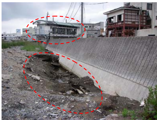
写真-24 前面側地盤の洗掘と水門の被害 (地点 o)
