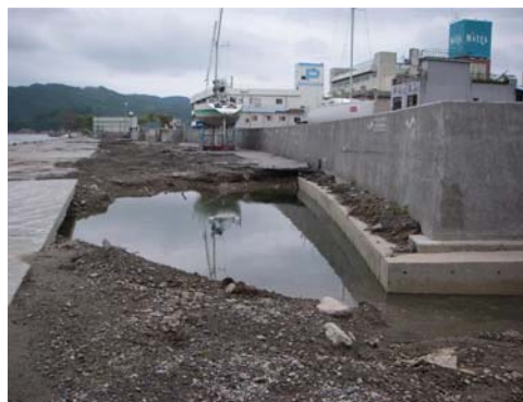
写真-26 前面側地盤の洗掘 (地点 q)
