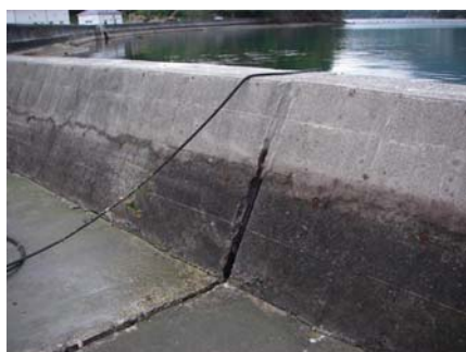
写真-8 防波堤の目地ずれ (左岸側防波堤)
