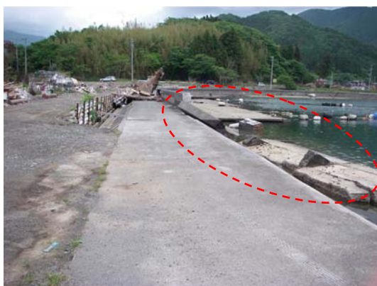
写真-15 堤防構造の被害（地点 k）
