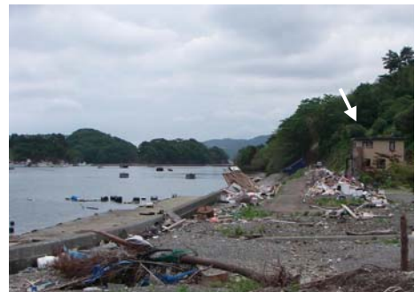
写真-18 地点 k 付近の建物
