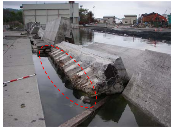
写真-29 鋼矢板折れ (地点 r)
