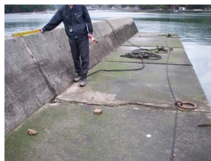
写真-9 防波堤の目地ずれ (左岸側防波堤)
