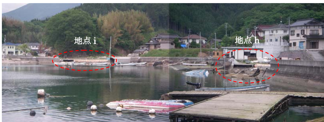
写真-11 永浜地区南側部分の状況
