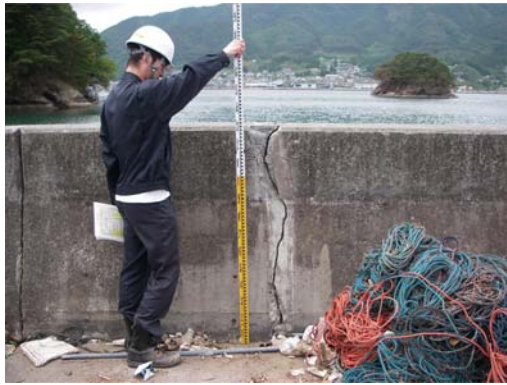
写真-1 堤体に発生したクラック（地点 a）
