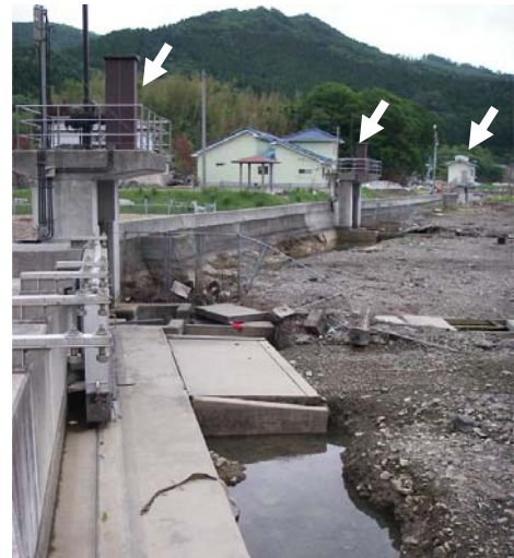
写真-14 水門と付近の被害（矢印が水門，地点 j）
