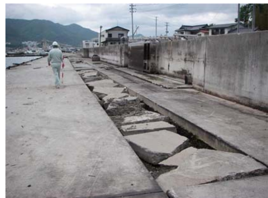
写真-19 物揚場の舗装の被害
