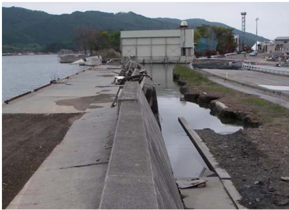
写真-28 背後側地盤の流出 (地点 r)
