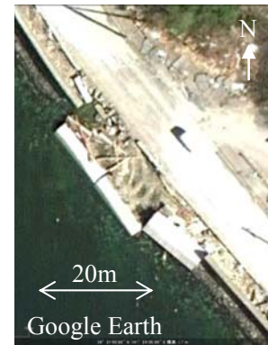
写真-4.1.10 上空からの写真
