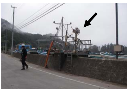
(1) 水門の操作施設の損壊
