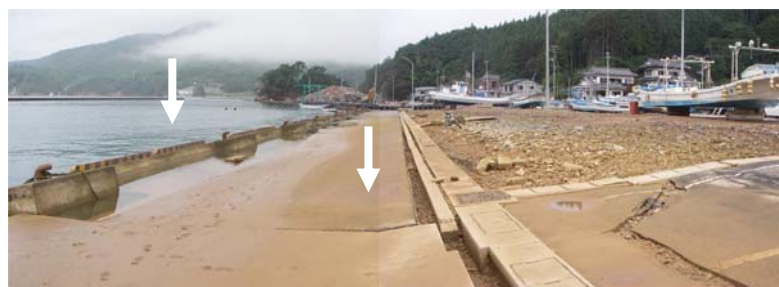
(2) 岸壁の変位と舗装部分の陥没
