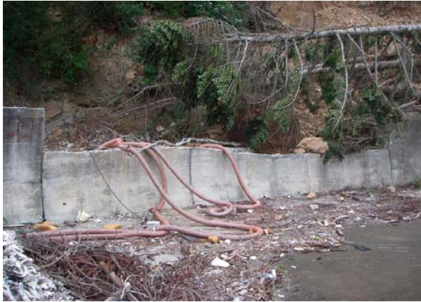
(1) 海側からみた状況
