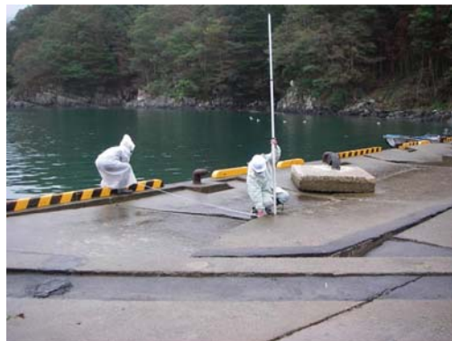
(1) 陥没した舗装
