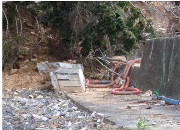
(2) 陸側からみた状況
