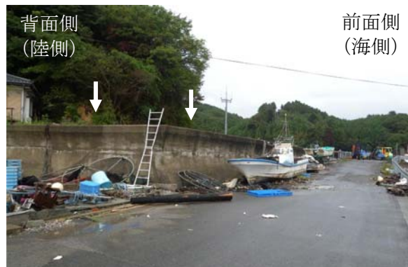
写真-4.3.5 被害のなかった胸壁 (地点 3-d)
