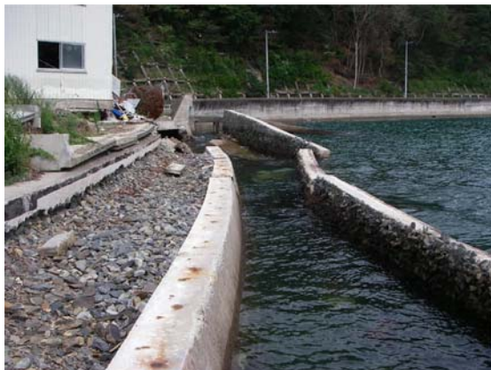
(1) 海側に倒壊した表のり
