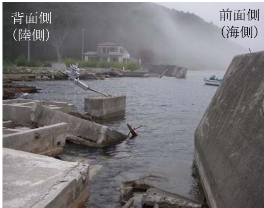
(1) 護岸の被害状況
