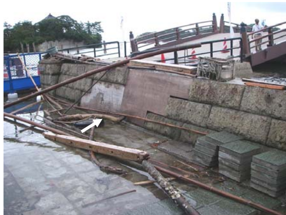
写真-4.5.2 空隙のできた胸壁 (地点 5-b)
