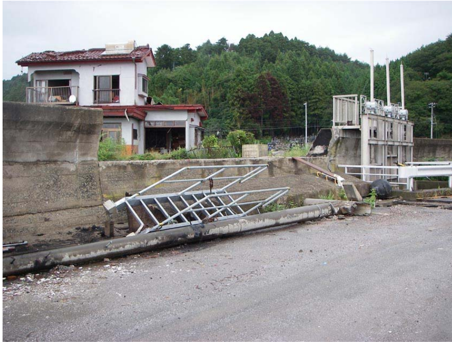
(1) 上部が折れた堤体（前面側からみた状態）
