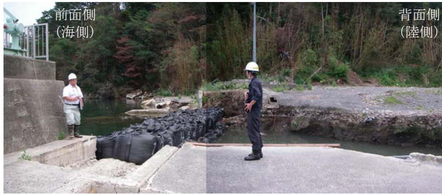
(1) 堤体及び背面側地盤が流出した護岸
