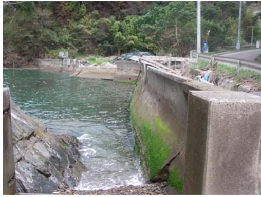
(1) 滑動した堤体 (海側からみた状況)
