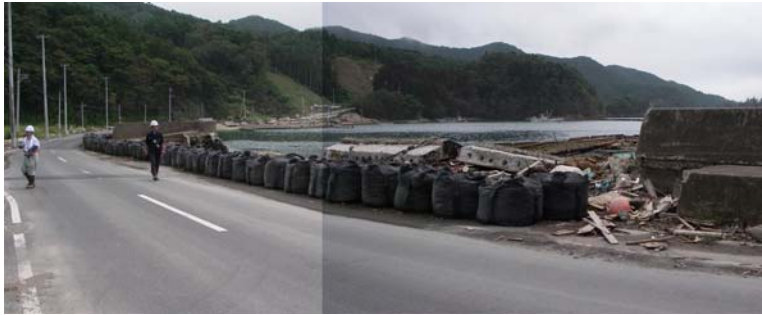
(1) 倒壊した護岸構造
