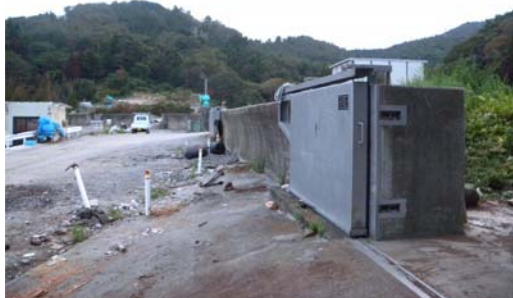
(1) 海側からみた状況
