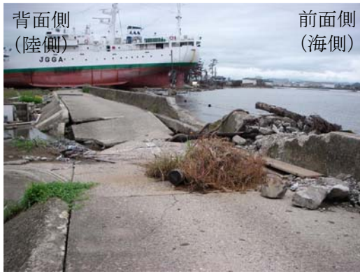
(1) 破壊された胸壁 (船舶は撤去済み)
