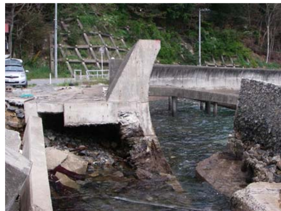
(2) 堤体断面の拡大写真
