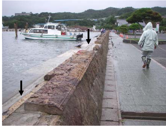
(1) コンクリート製基部が一部で露出した胸壁
