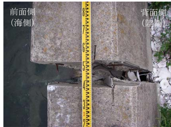
(3) 目地開きの拡大写真 (上からみた状況)
