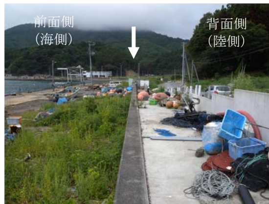
写真-4.1.5 ほとんど被害のなかった胸壁（地点 1-e）
