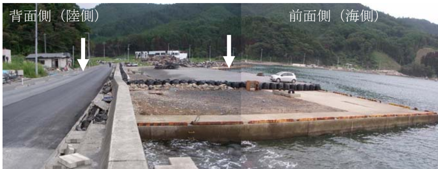
(1) 舗装打ち直しされた背面側地盤と嵩上げされた物揚場
