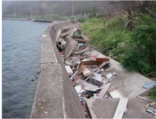
(1) 法線が入りしている堤体と落下・傾斜している天端被覆板
