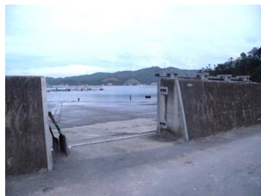
(2) 陸側からみた状況
