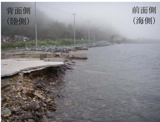
(1) 流失した護岸及び地盤
