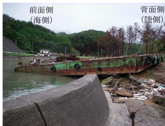
写真-4.3.2 護岸に乗り上げた台船 (地点 3-b)
