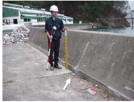
写真-4.1.16 沈下した天端被覆板 (地点 1-m)
