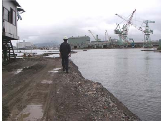
(1) 水路沿いの地盤
