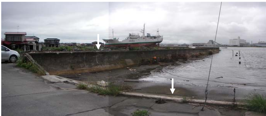
写真-4.4.4 地点 4-b の天端高さ (奥の矢印) と 4-c の天端高さ (手前の矢印) との比較
