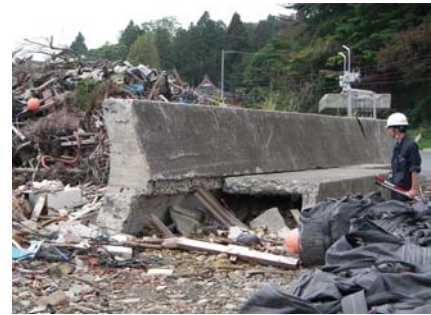
(2) 護岸構造の断面
