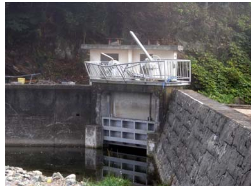
写真-4.1.22 損壊した水門の操作施設 (地点 1-s)
