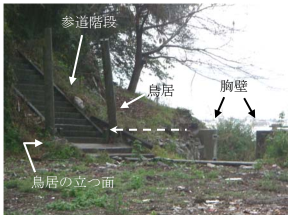
(3) 胸壁の天端と参道階段との比較
