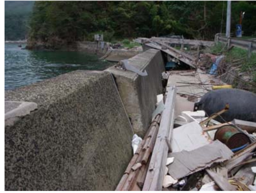
(2) 滑動した堤体 (陸側からみた状況)
