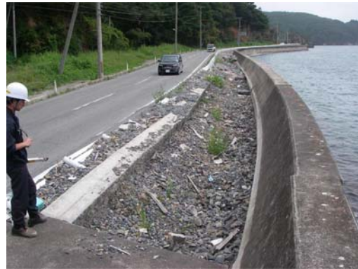
写真-4.1.8 背後側地盤の洗掘 (地点 1-h)
