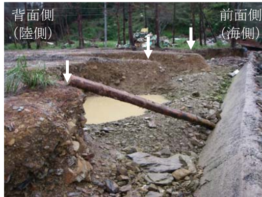
(4) 崖状になった背後地盤
