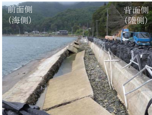
(1) 海側に倒れた表のり(左)と落下した天端被覆板(右)
