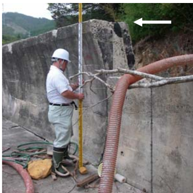
写真-4.2.3 上部が折れた堤体 (地点 2-c)
