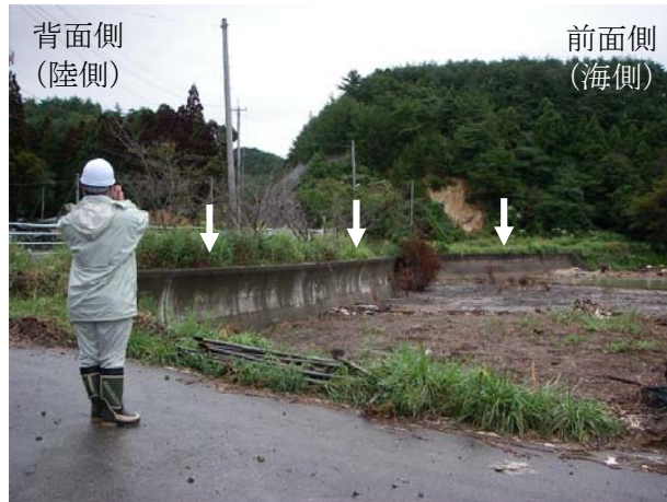
写真-4.3.7 被害のなかった胸壁 (地点 3-f)
