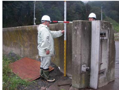
(2) 天端高さの測定
