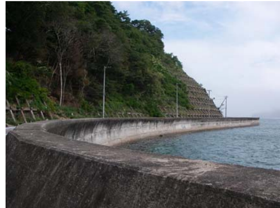
写真-4.1.12 被害のない護岸
