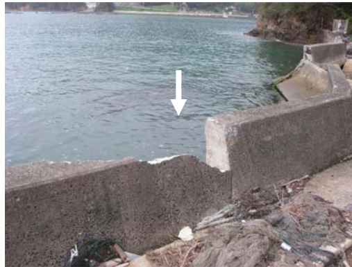
(3) 欠損している堤体
