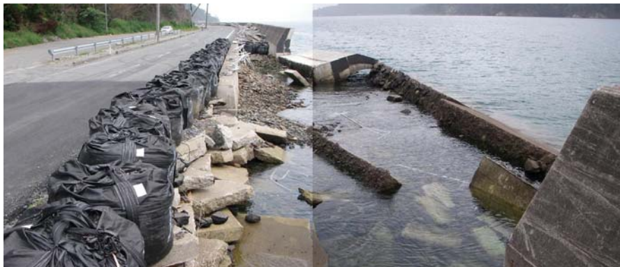
写真-4.1.9 海側に倒壊した護岸 (地点 1-i)
