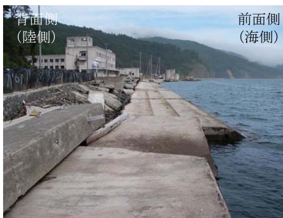
(1) 海側に倒壊した表のり
