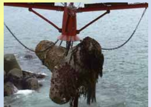
網チェーン装置によるブロック撤去作業
