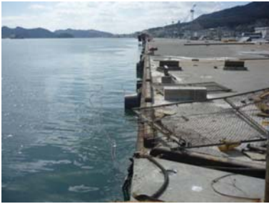
写真-14 岸壁法線の状況（異常なし） 外れた鋼製渡版
