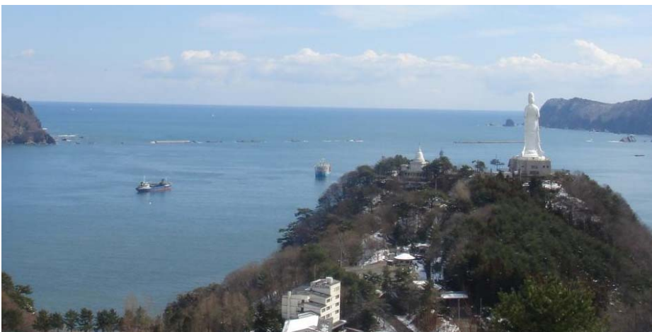
写真-4 釜石湾口防波堤全景
