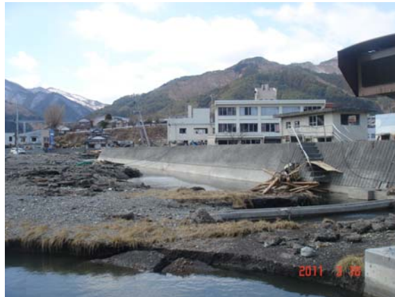
写真-13 洗掘された防潮壁
