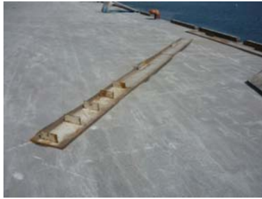
写真-14 岸壁法線の状況（異常なし） 外れた鋼製渡版
