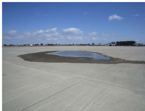
写真-17 液状化による駐機場舗装の沈下
