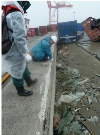
写真-12 約1.4mの段差
