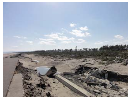
写真-21 護岸とその背後の洗掘（南側）
