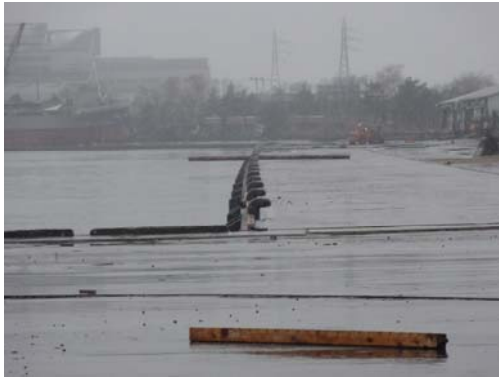
写真-1 大手埠頭西側の様子
