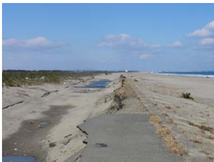
写真-20 護岸とその背後の洗掘（北側）
