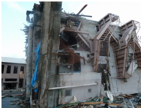
写真-19 転倒した4階建ビル。左端に杭がぶら下がっている
