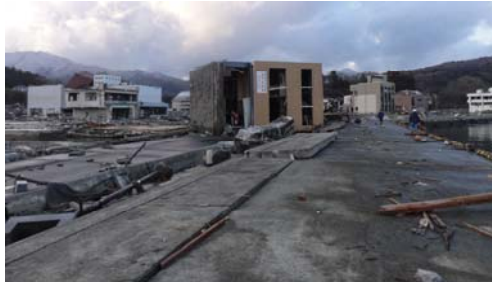
写真-18 岸壁近傍で倒壊した鉄骨造の建物
