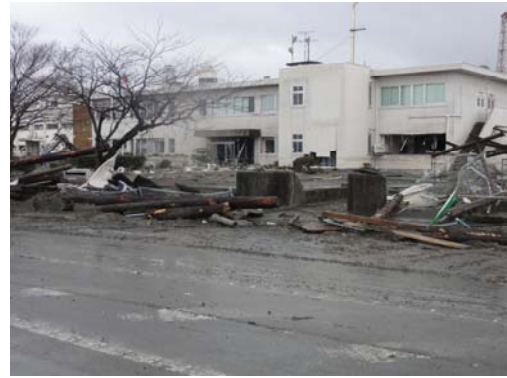
写真-2 大手埠頭背後の合同庁舎
