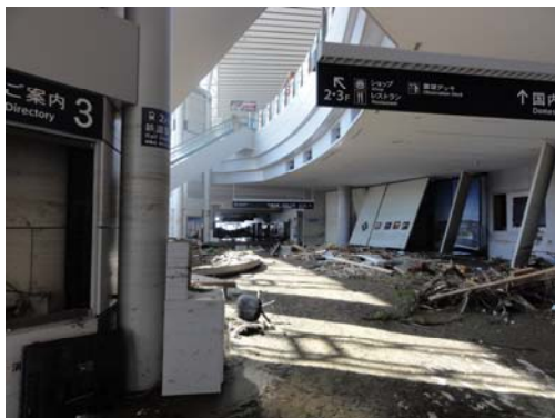
写真-14 ターミナル内部の様子
