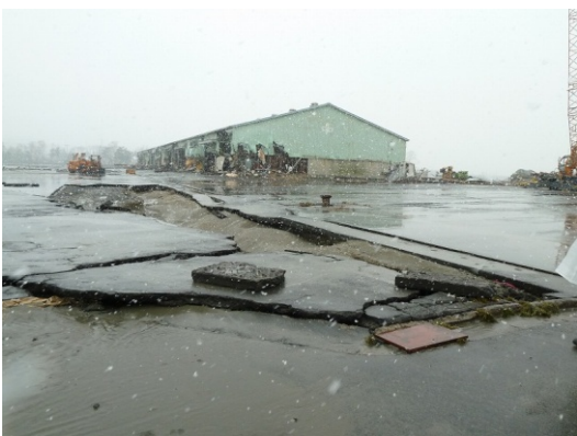
写真-5 荷さばきヤードの洗掘による沈下・陥没
