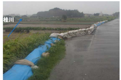
水防団による水防活動(土のう積み)
