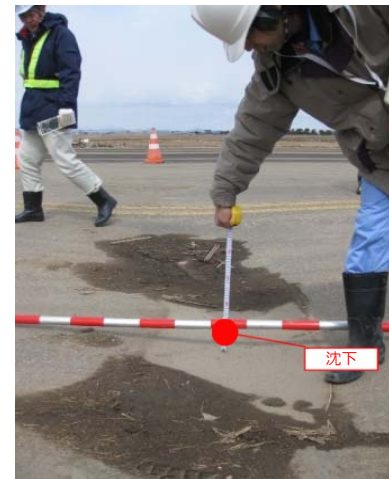
仙台空港の誘導路(アスファルト舗装)の液状化による局所沈下
