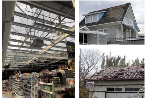
平成30年台風第21号と令和元年台風第15号の強風による屋根ふき材の被害例
