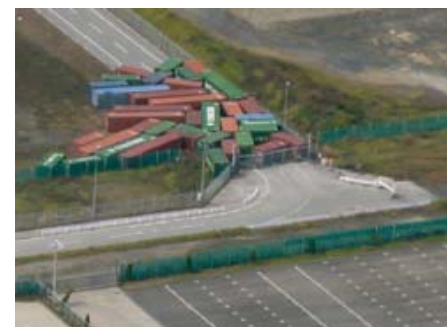
台風18号 (H21年10月) による三河港の高潮浸水
