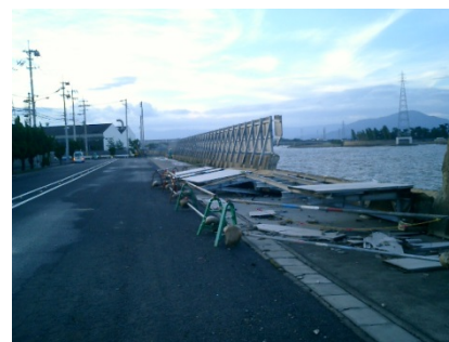
台風16号 (H16年8月) に よる丸亀港の防潮壁被害
