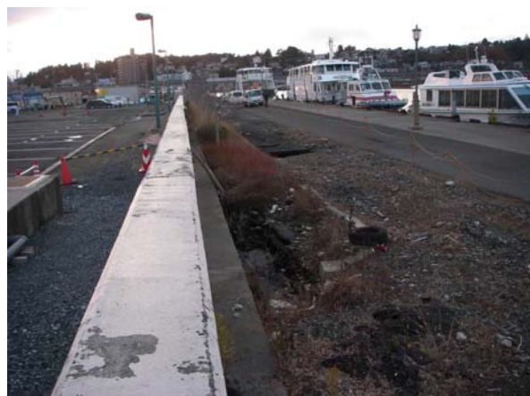
写真-31 陸側と海側の地盤の洗掘（地点7-f）
