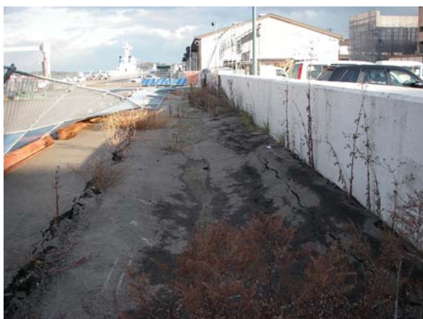
写真-30 舗装ひび割れと不同沈下（地点7-e）
