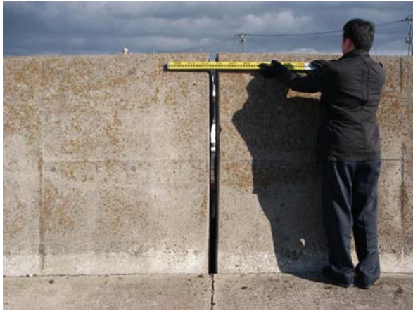
(3) 堤体間の目開き（最大 6 cm, 陸側からみた状況） (4) 胸壁の天端高さの測定
