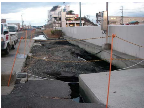
(1) 海側地盤の洗掘
