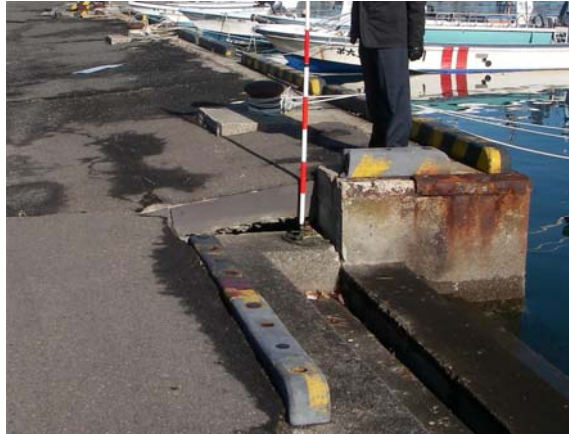
写真-8 岸壁周辺の不同沈下 (地点 2-b)
