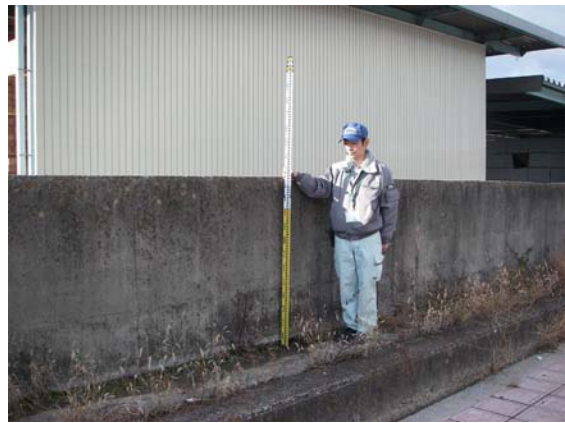
(2) 胸壁の天端高さの測定状況
