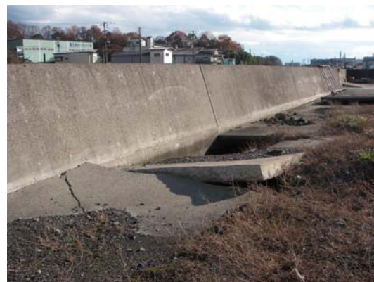
写真-23 陸側地盤の洗掘 (地点 6-d)
