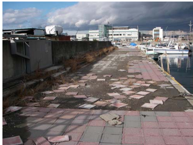
写真-21 海側の物揚場の舗装がはがれている状況（地点 6-b）
