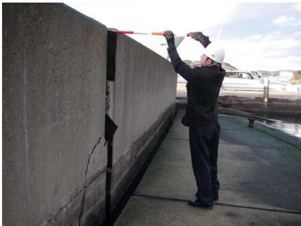
(3) ずれの大きさの測定 (イ)
