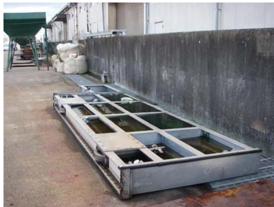
写真-29 陸閘の門扉の被害（地点 7-d）
