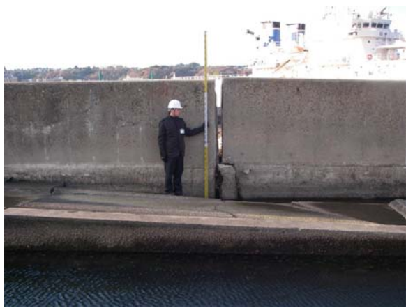
(2) ずれの大きさの測定 (ア)
