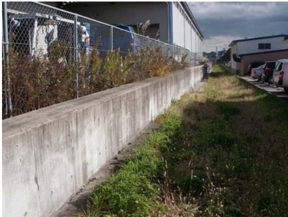
写真-13 地点 4-a (左が海側, 右が陸側)
