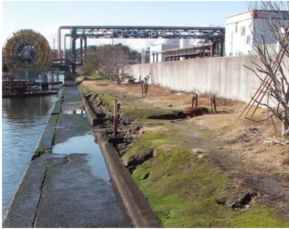
(1) 海側地盤の状況
