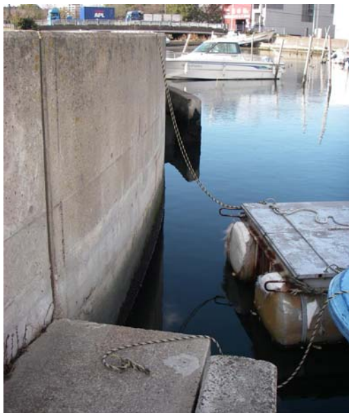
(1) 流失している海側地盤
