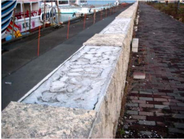
写真-34 堤体の化粧板が剥がれる被害 (地点 7-h と地点 7-i の間の区間)
