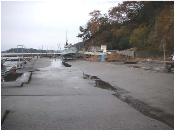
(1) 海側地盤の状況
