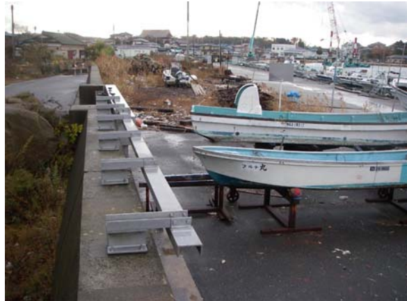
(2) 被害のない堤体
