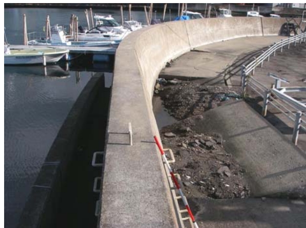
(2) 陸側地盤の洗掘
