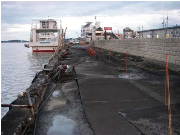
(1) 胸壁の海側地盤の状況
