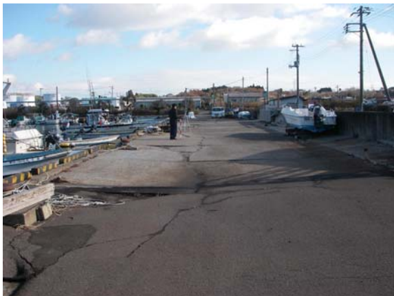
(1) 海側地盤の状況
