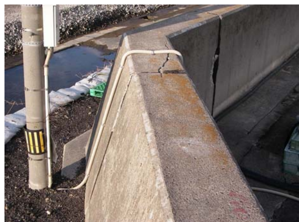
(2) (1)の左下のひび割れ部分
