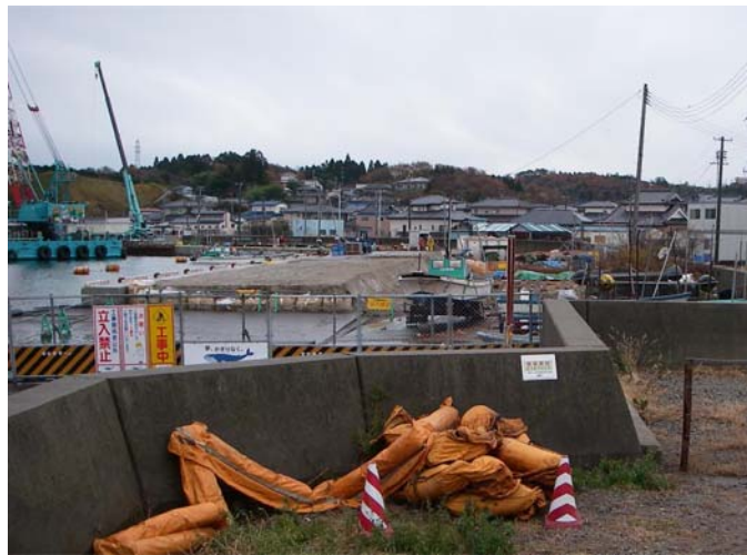
写真-2 海側地盤を嵩上げる復旧工事の状況
