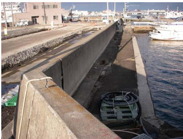
(1) 陸側地盤の嵩上げと堤体のひび割れ
