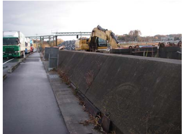
写真-5 東宮地区胸壁（南側部分）
