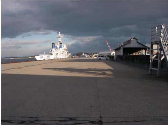
(1) 栈橋式のみ頭（被害なし）
