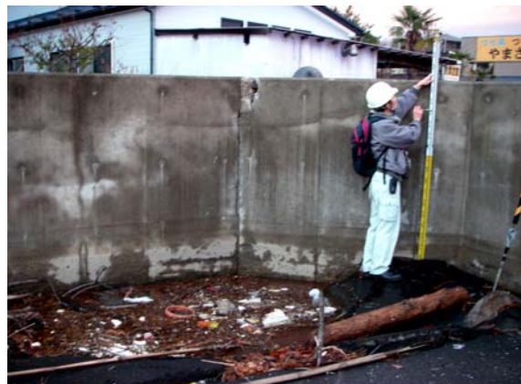
(4) 海側地盤の洗掘
