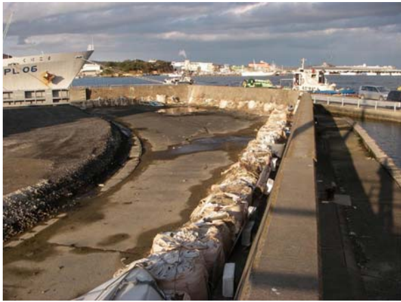
(1) 引き波による胸壁堤体の海側への変位
