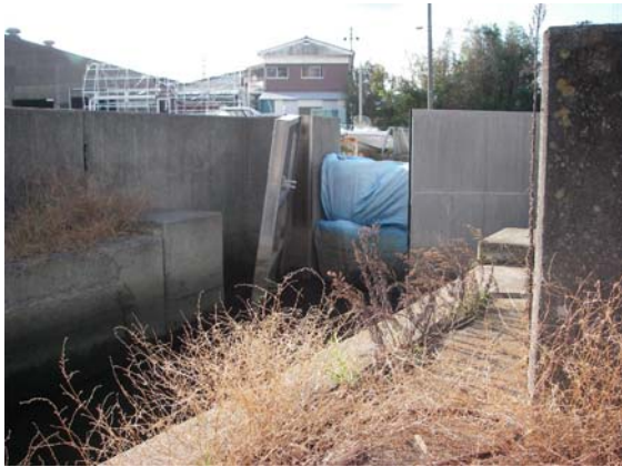
(1) 海側からみた状況
