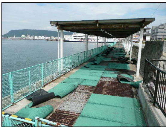
写真－1 護岸の被災（高松港）
