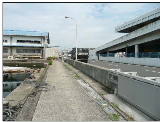
写真－2 整備された防潮壁（高松漁港）
