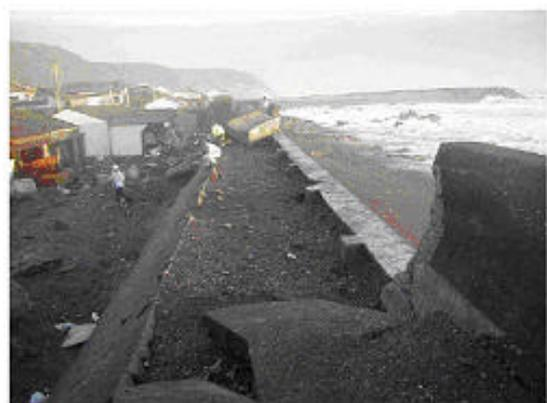
写真-5.3 高知県菜生海岸の被災状況
