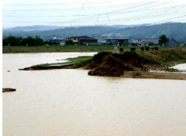
写真-1.1 五十嵐川三条市内の破堤状況
