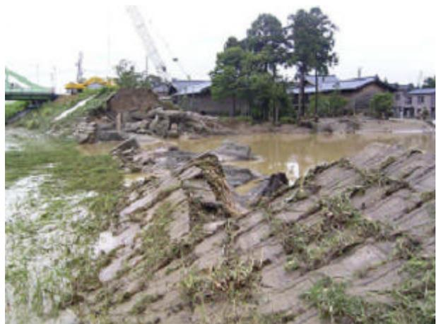
写真-1.3 刈谷田川中之島町内の破堤状況
