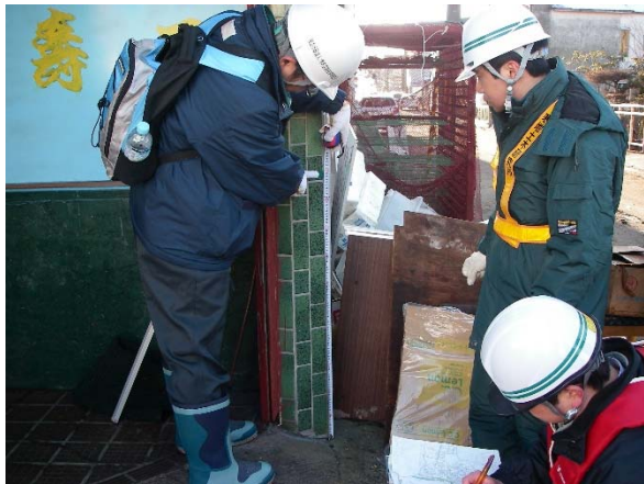
写真－１ 市街地の浸水痕跡の例 (弥生町 1 丁目)
