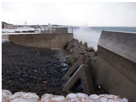
(１) 南側から見た状況
