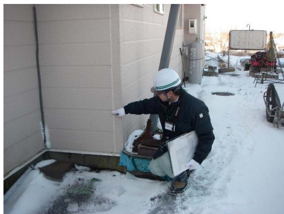
写真－２ 民家の浸水高さの測定 (幌茂尻漁港 (幌茂尻地区))
