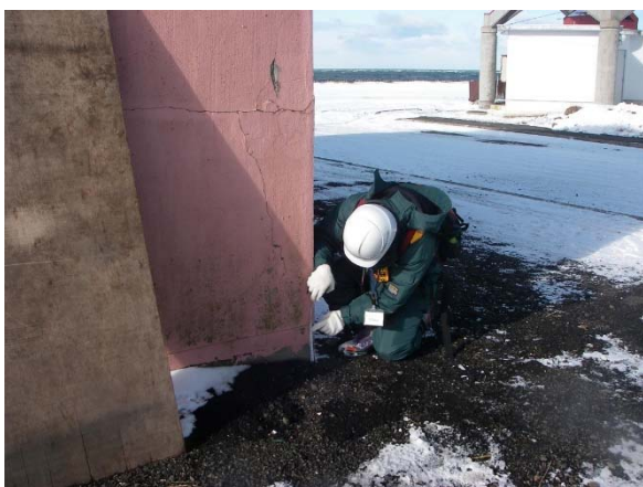
写真－３ 浸水高さ（推定）の測定 (幌茂尻漁港 (温根沼地区))
