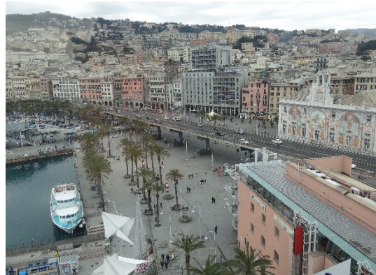
写真 19 ジェノバ (再掲) 都市高速(高架)の下の通過交通の道路を地下化し、港湾再開発地区(写真左側)と背後の市街地(写真右側)を連結させている。
