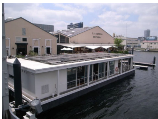
写真 35 東京港（再掲） 水面上に浮体構造物（建築物かつ船舶扱い）として作られたレストラン。
