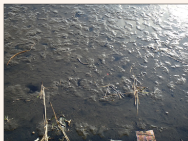
Hiビーズ敷設前（ヘドロ状況）
