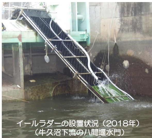
《イールラダーパネル（長さ約1.7m×幅約0.4m）》
