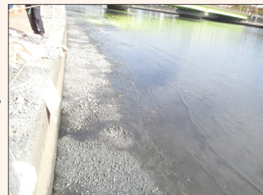
Hiビーズ敷設完了状況（幅20cm）
