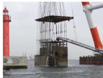
既存ケーソンを 新設防波堤の一部に転用
