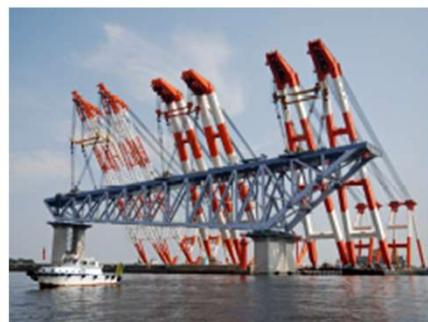
施工時の安全確保事例
