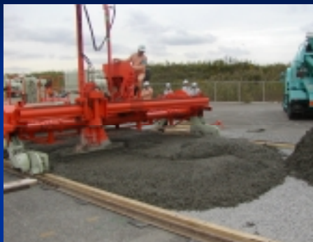
スプレッダによる敷き均し
