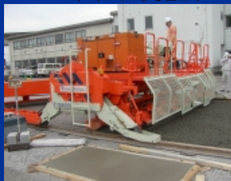
フィニッシャによる仕上げ
