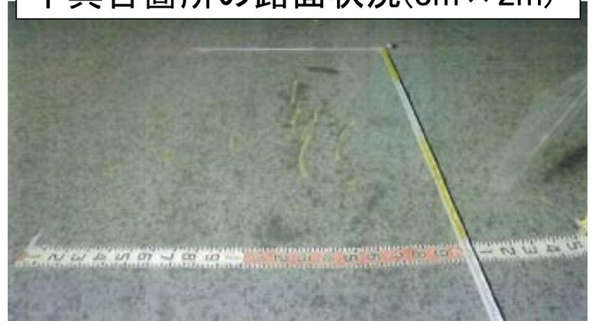
拡大写真(液体の染出し)
