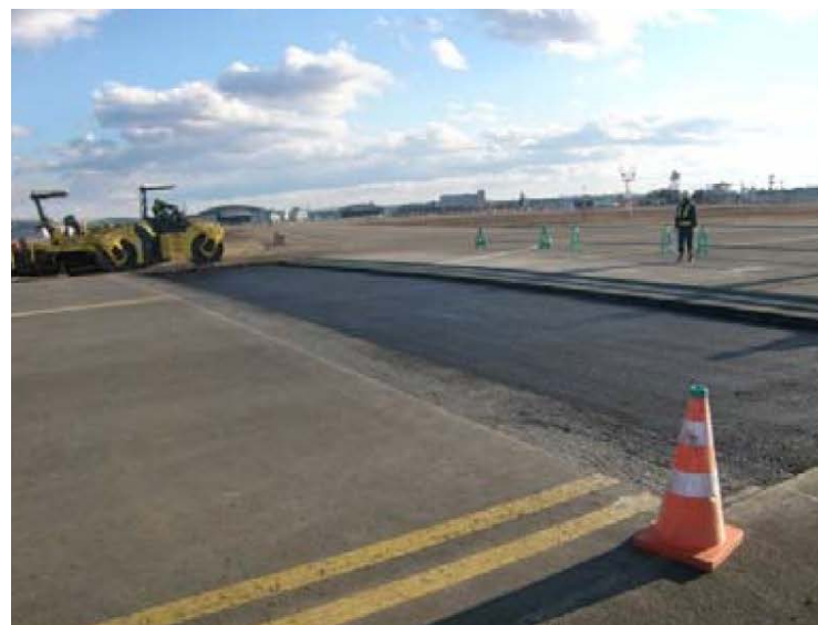
打替え事例(2011年仙台空港誘導路)
