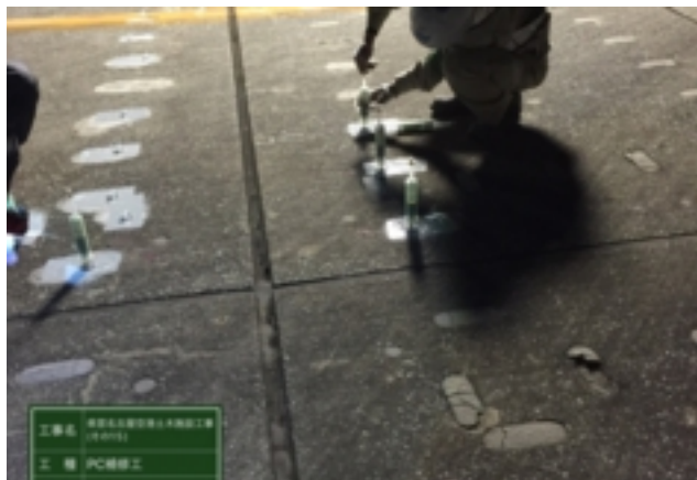
県営名古屋空港のPC舗装での 施工状況
