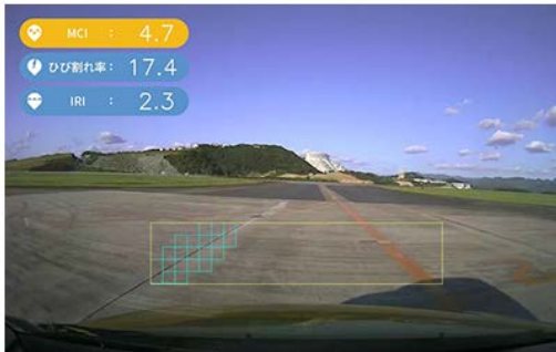
ドラレコで撮影した空港内駐機エリアの分析画像 (青い四角が損傷検知箇所)
