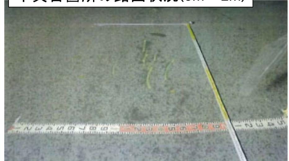
拡大写真(液体の染出し)
