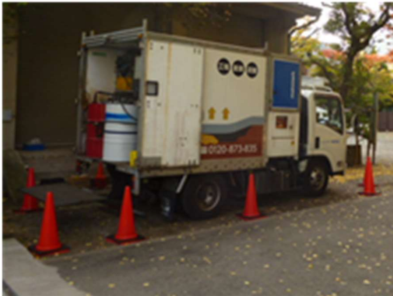
樹脂を搭載した作業車両
