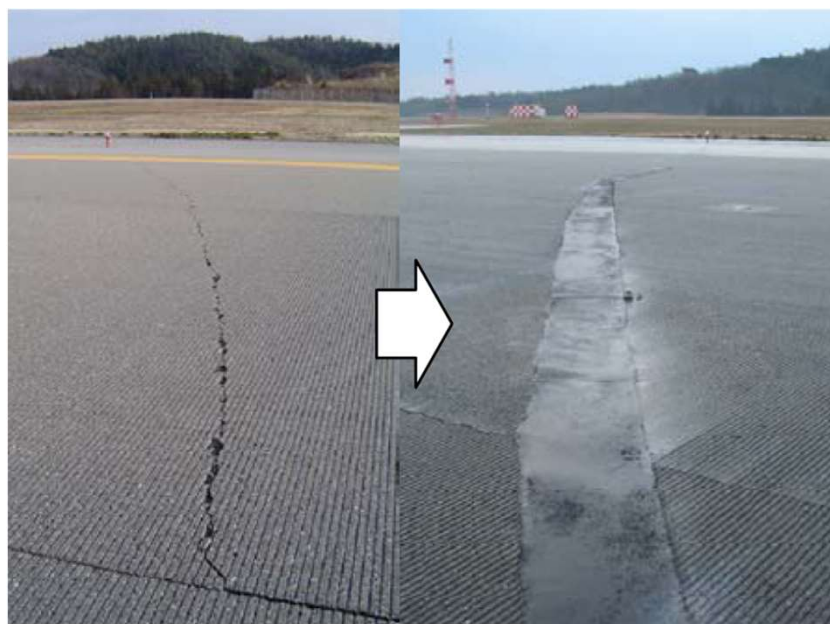
摺り付け事例(2007年能登空港滑走路)
