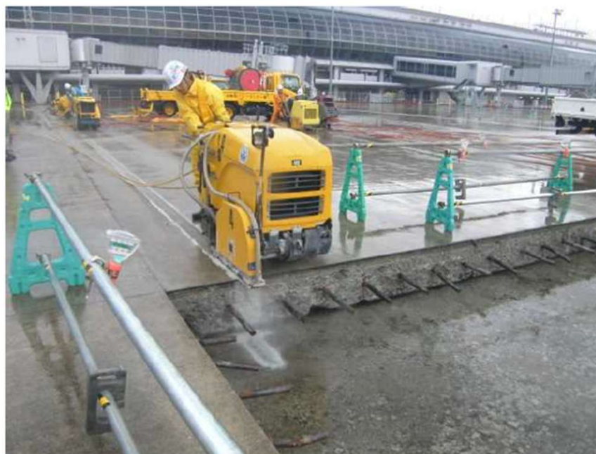
図-4. 3 ブロック状に切断する応急復旧の例 (2011年仙台空港)
