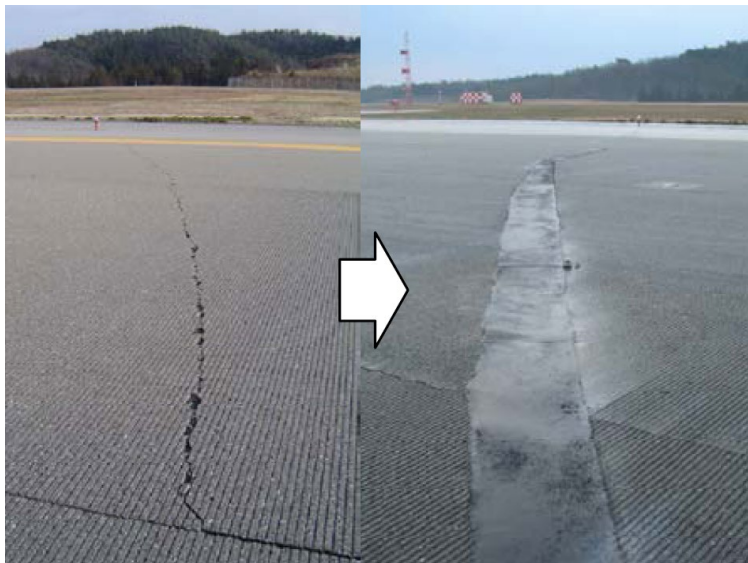
摺り付け事例(2007年能登空港滑走路)
