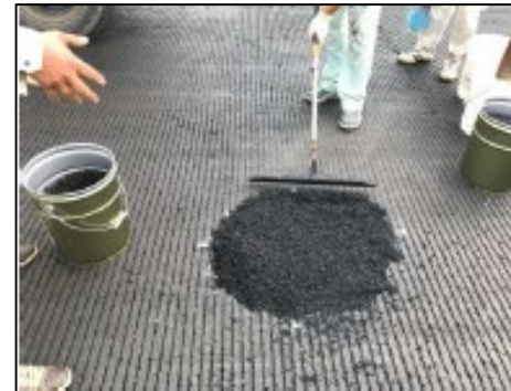
常温混合物 による応急復旧
