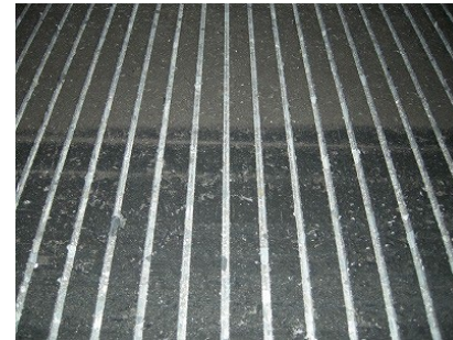
健全な グルービング
