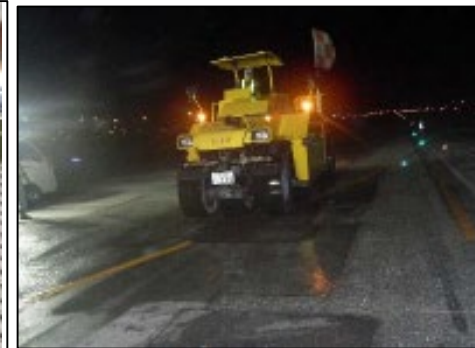
加熱混合物 による本復旧
