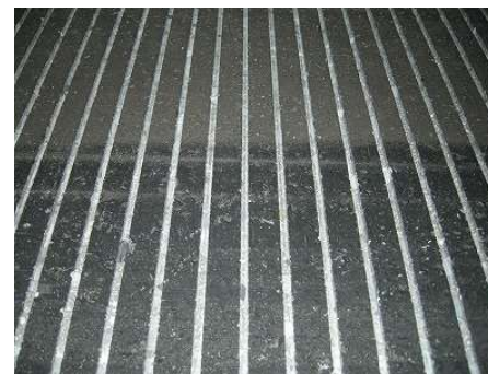
健全な グルービング
