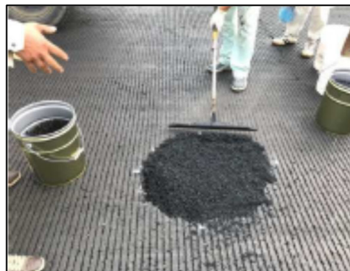
常温混合物 による応急復旧
