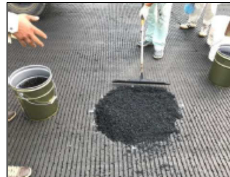
常温アスコン による応急復旧
