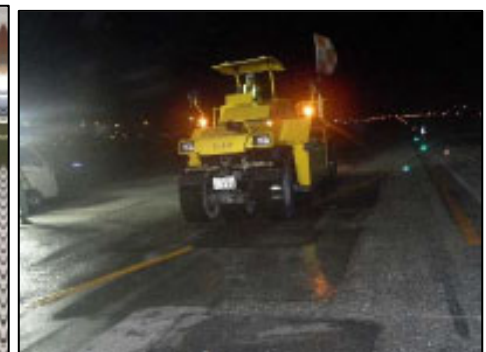
加熱アスコン による本復旧
