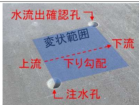
舗装完成後に注水孔の設置
