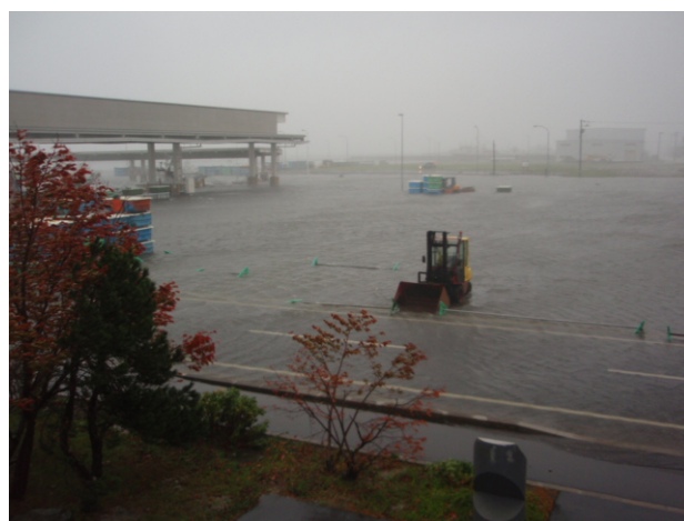
写真-4.9 標津漁港における浸水状況
