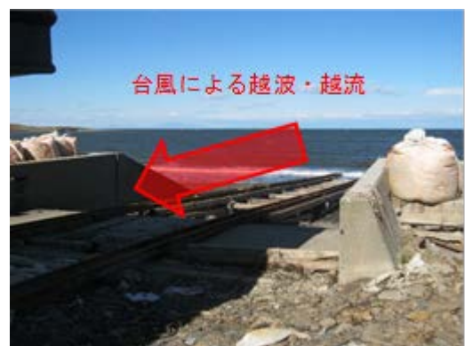
写真-2.13 穂香地区②（造船所斜路）
