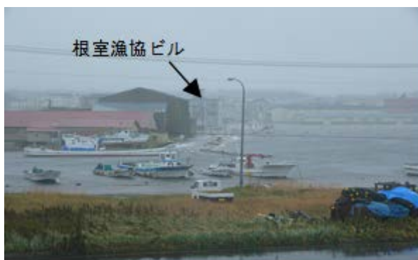
写真-2.1 海岸町①（浸水状況：10/8 10:20a.m.）
