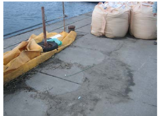
写真-2.7 弥生町④（土のうの設置跡）
