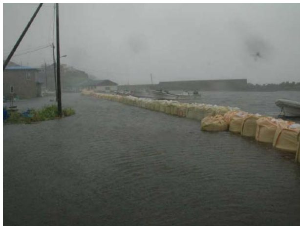
写真-4.4 大型土嚢の設置状況
