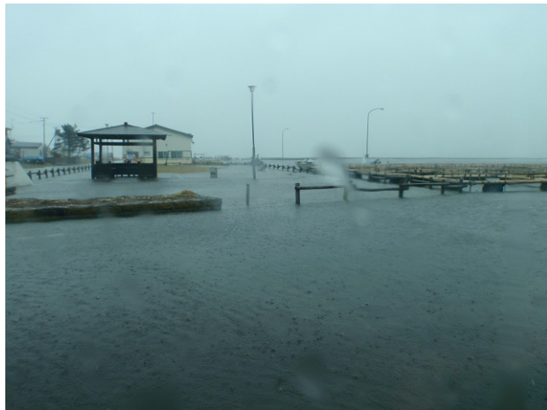
写真-4.6 走古丹漁港における浸水状況
