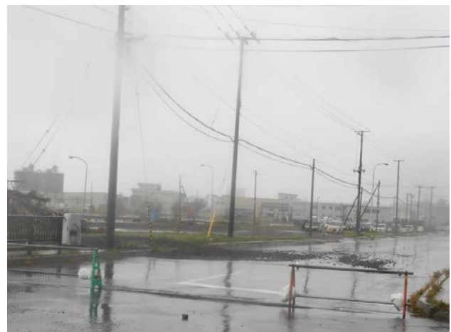
写真-4.11 網走港における浸水後の状況
