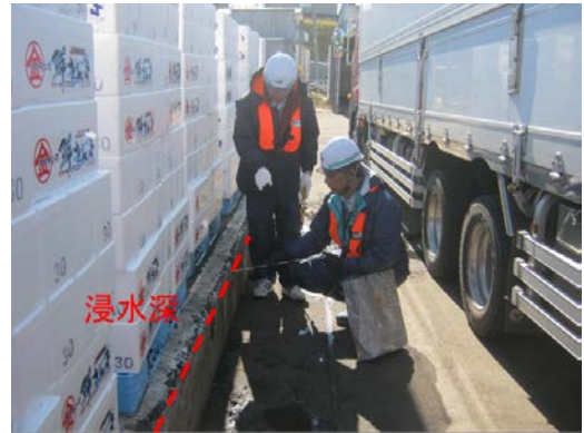
写真-2.10 西浜町②（食品加工工場内）
