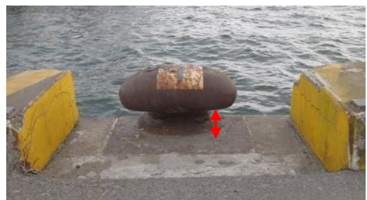
図 4.10 係船柱の胴部の高さ
