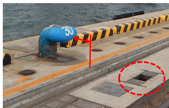
図 4.5 荷役機械用の溝や箱抜きの近接
