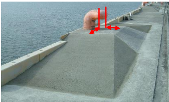
図 4.8 係船柱の嵩上げ②
