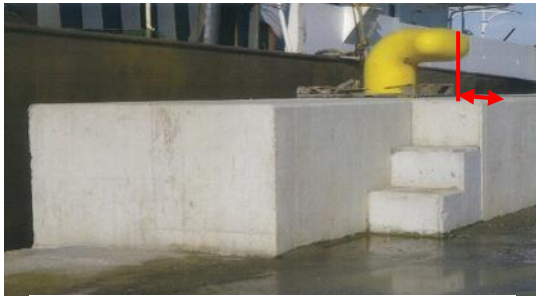
図 4.7 係船柱の嵩上げ①
