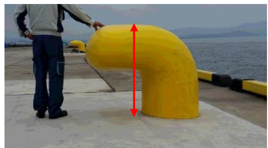
図 4.11 係船柱の高さ
