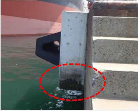
図 4.17 防舷材のコンクリート製の台座
