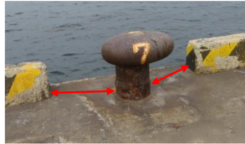
図 4.18 車止めの係船柱からの離隔
