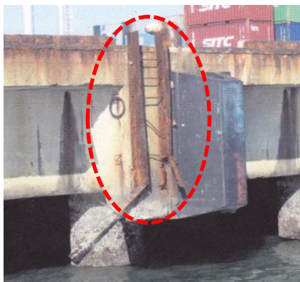
図 4.29 岸壁側面に突出したはしご
