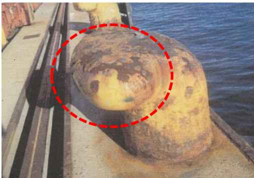
図 4.9 係船柱の頭部の出幅
