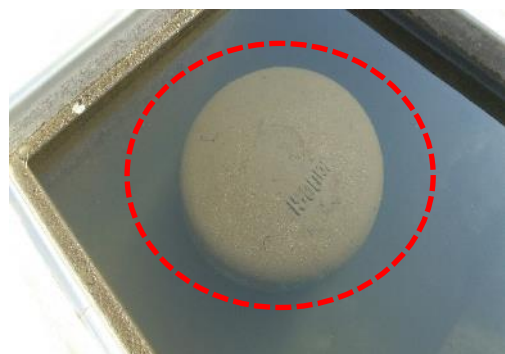
図 4.12 係船柱の箱抜きの中への設置（通常は通行に支障がないよう鋼製の蓋がされている）
