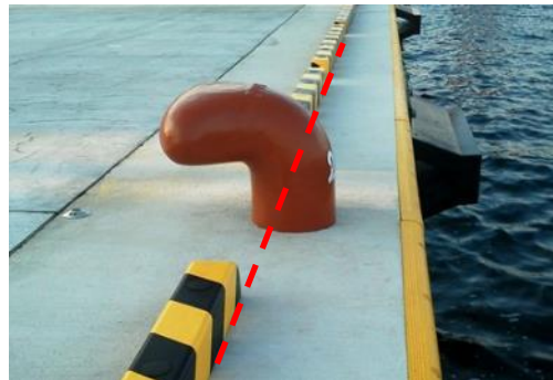
図 4.19 車止めを係船柱の陸側に配置 (安全性向上事例)
