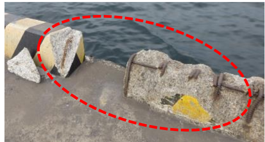
図 4.35 天端が欠けた車止め
